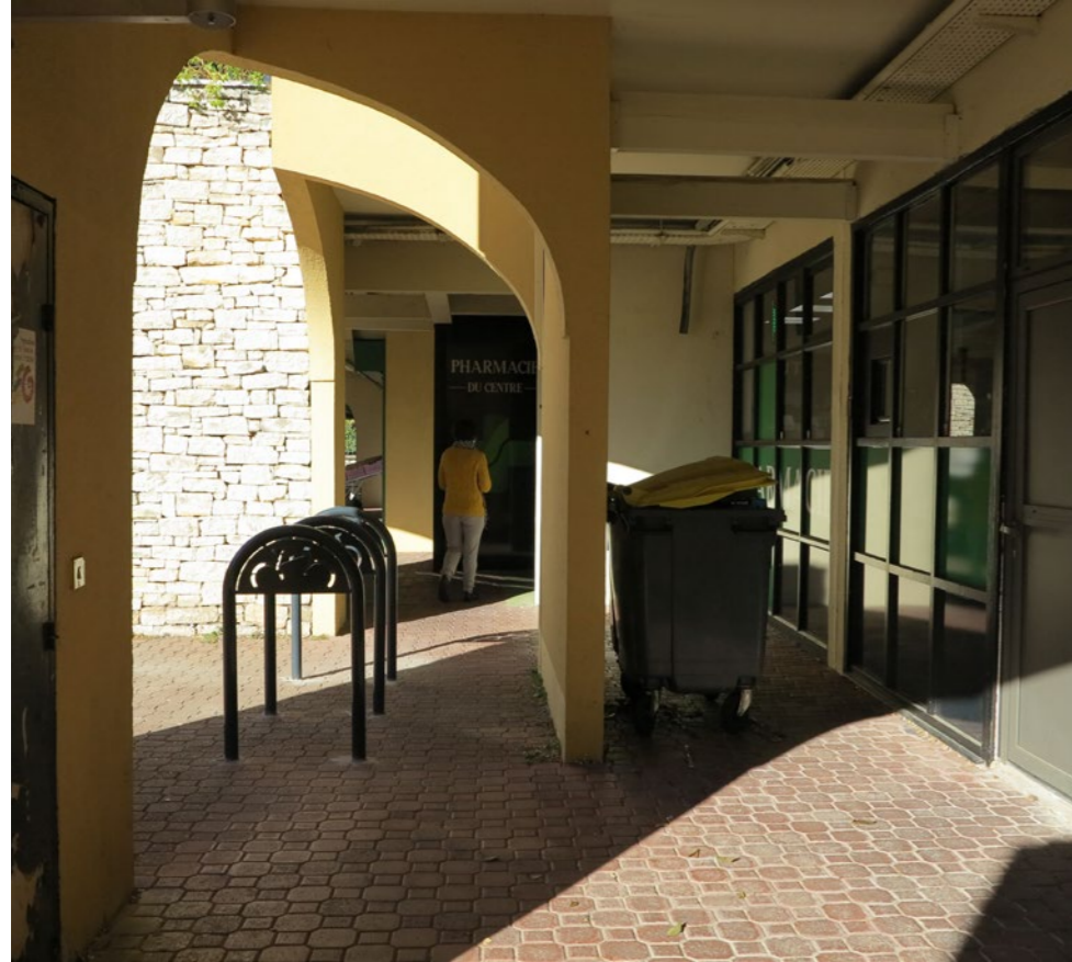
↑ La liaison entre rez-de-chaussée et place encombrée par le portique et mobiliers.
