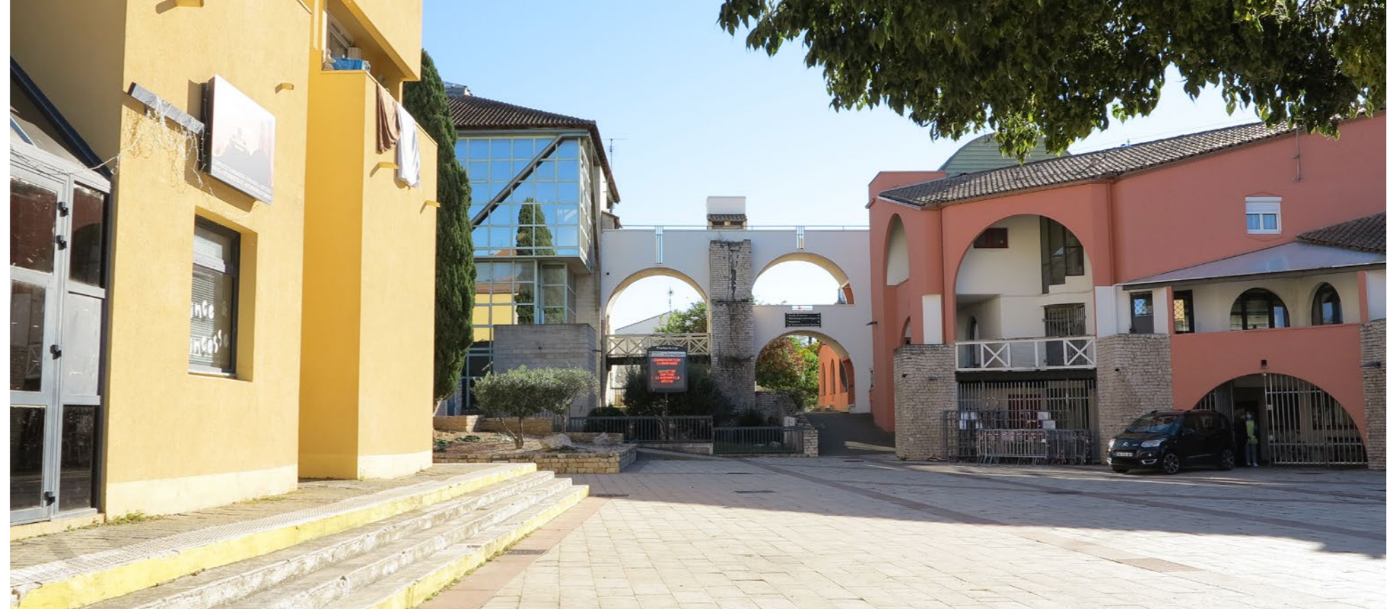
↑ Manque de connexion entre la place, le bâtiment central et la cantine. Les façades sont fermées.
