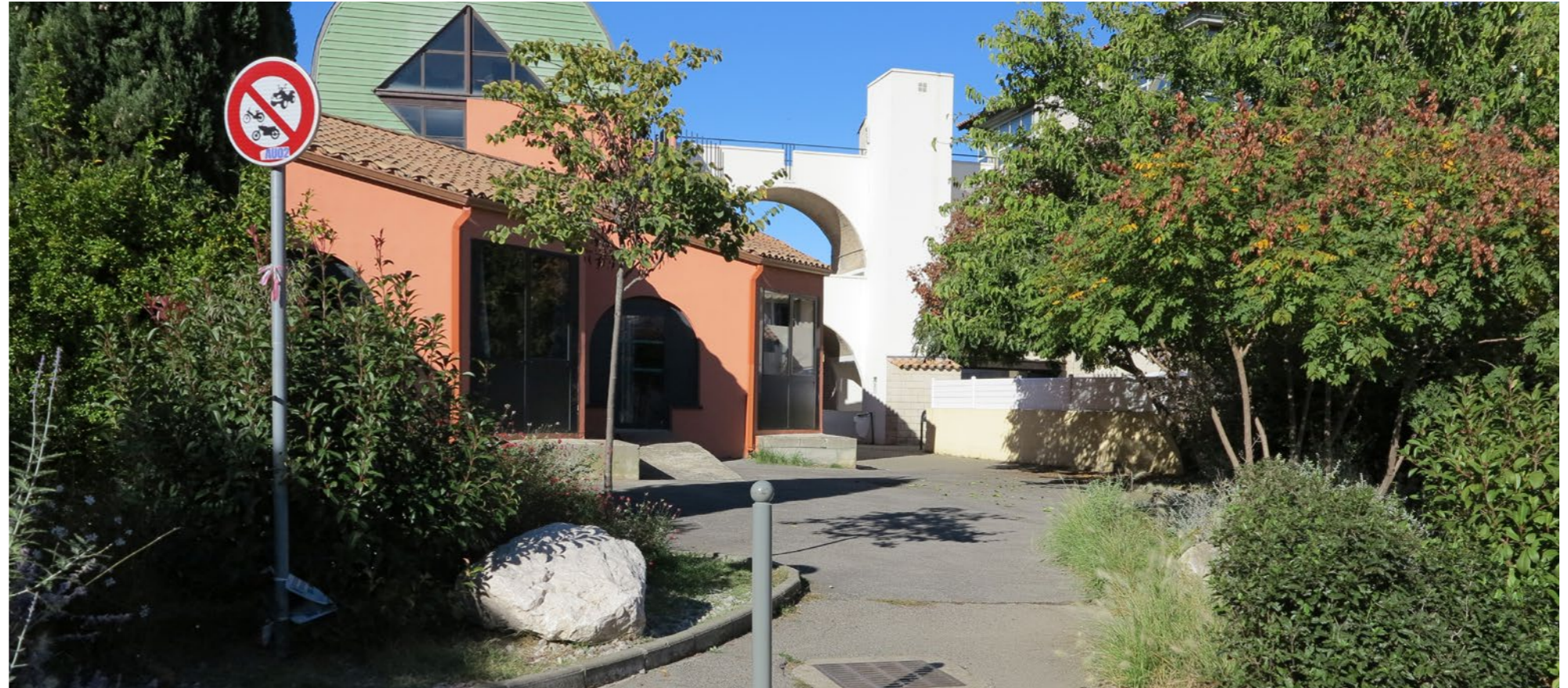
↑ Un aménagement routier, morcelé et non qualifié
